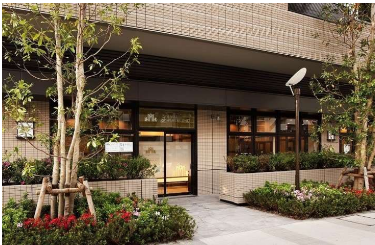
武蔵小杉駅の近くにある同院の外観（クリニック提供）
